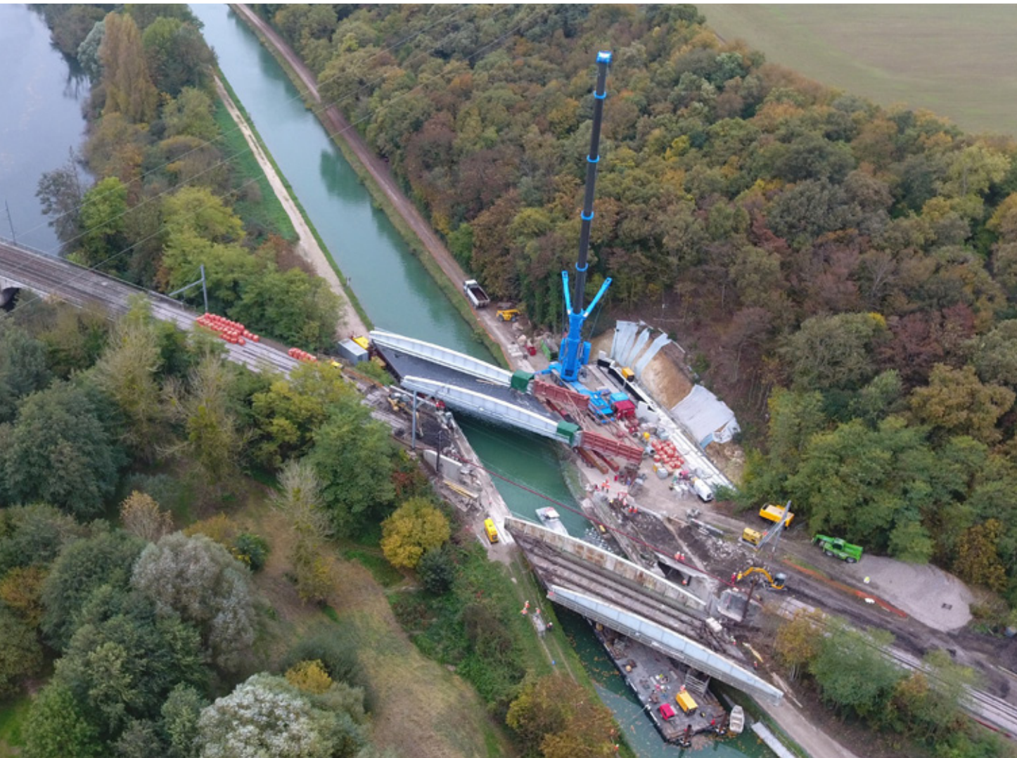
Remplacement du pont ferroviaire de Souppes-sur-Loing
