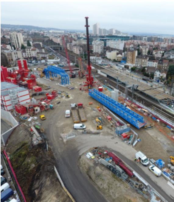
Grutage d'une passerelle piétonne en gare de Clamart
